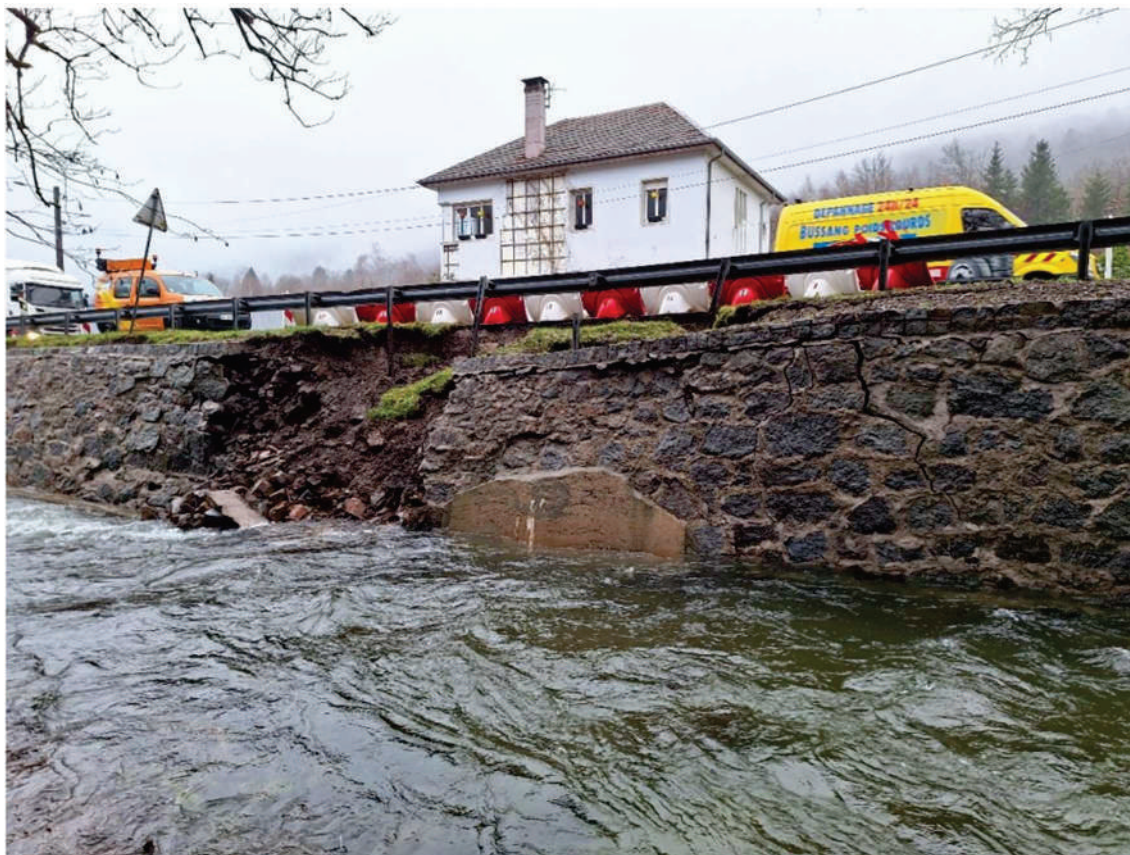
Vue de l'effondrement du mur au PR 33+790 (document [3])
